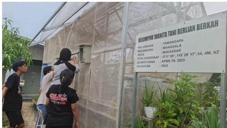
Gambar 3.3 Proses Pemasangan Sistem di Lokasi
